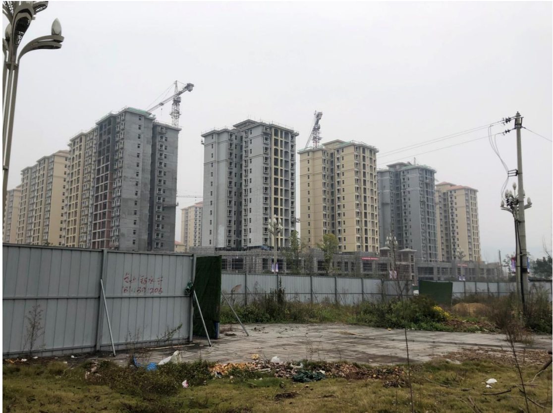
图片3 项目区打围现状（2020年4月拍摄）
